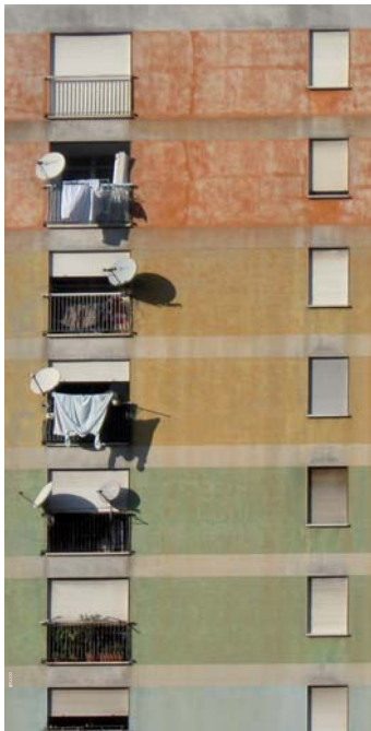
Brescia. Costruzione del quartiere di via Piaz. A destra: San Polo, Torre Tortonello 2011.
